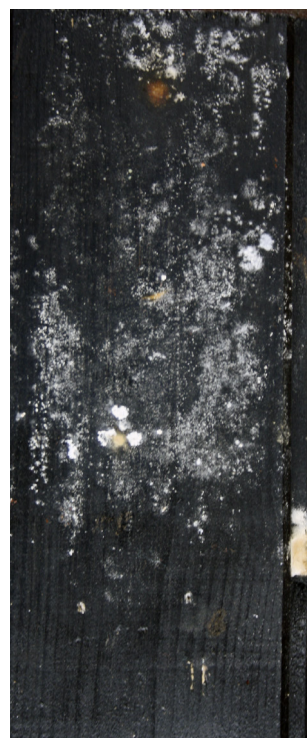
uitlogten brandvertrager door coating
